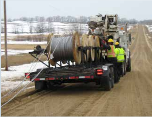
April: Stringing Line
